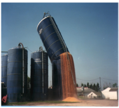
Figura 8. Rotura de un silo
