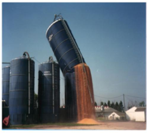
Figura 8. Rotura de un silo
